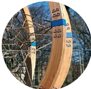
Wir nutzen Brettschichtholz, auch Leimbinder genannt, weil es besonders langlebig und tragfähig ist. Da es aus getrocknetem Holz gefertigt wird und mehrschichtig aufgebaut ist, findet Rissbildung in ausgesprochen geringem Maße statt. Die Tragfähigkeit verstärkt sich dadurch, dass Brettschichtholz aus vorsortierten und von Fehlstellen befreiten Hölzern hergestellt wird.
